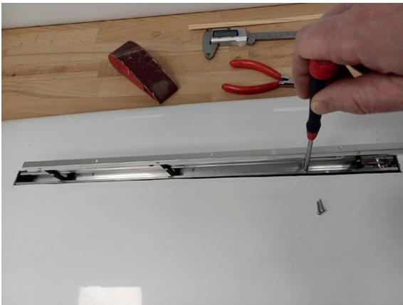
Befestigen Sie die Störklappe mit geeigneten Schrauben auf den Holzblöcken.
